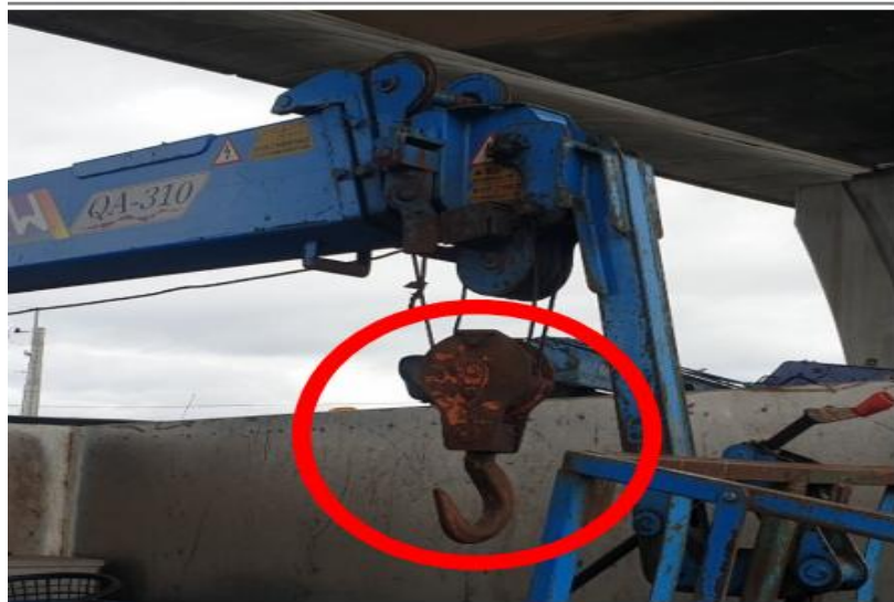
常見缺失樣態-吊鉤未裝防滑舌片
