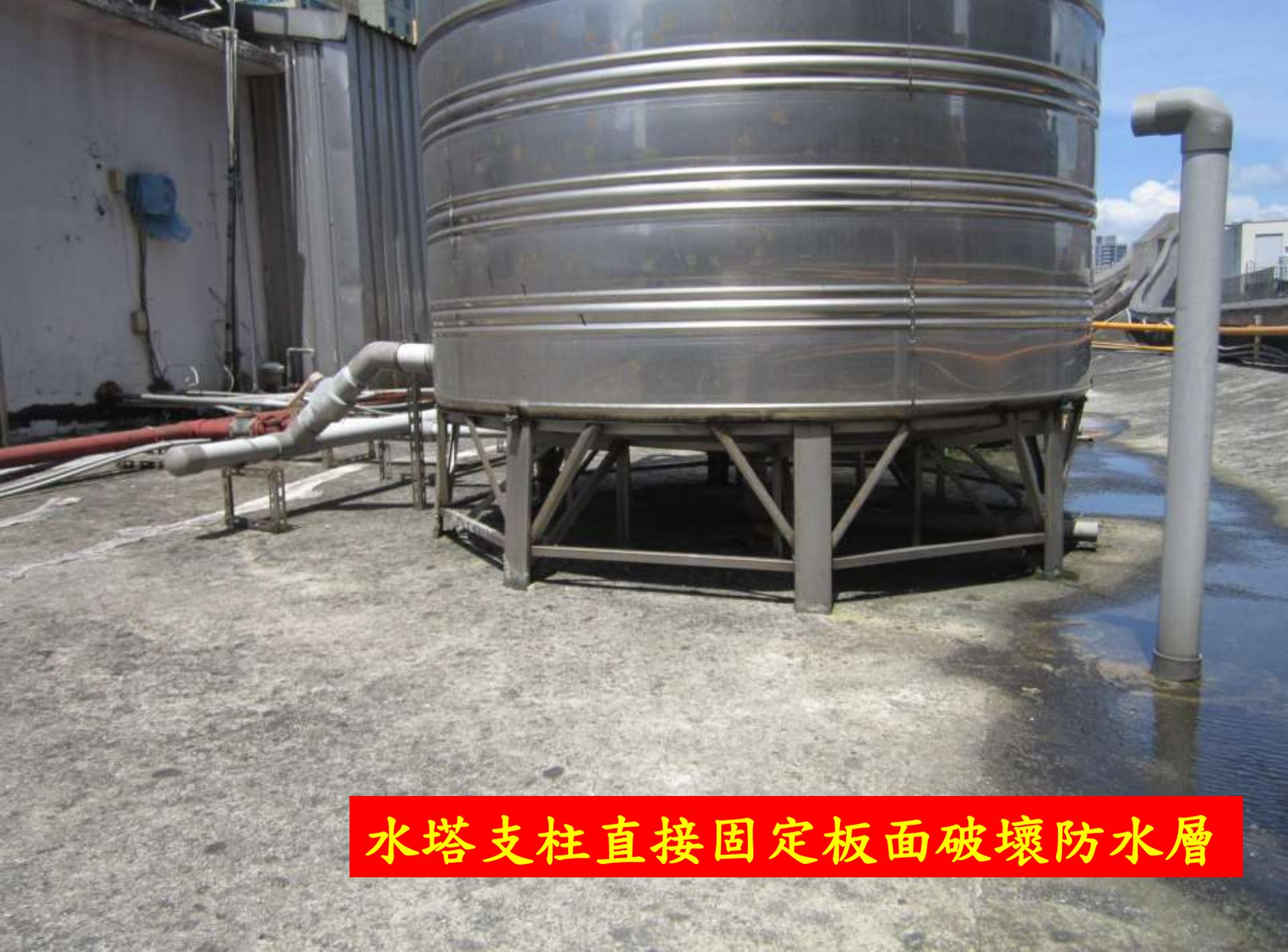
**水塔支柱直接固定板面破壞防水層**
