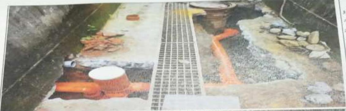
說明：埋設污排管之地坪敲擊線形凌亂, 重新打除 (改善中)
