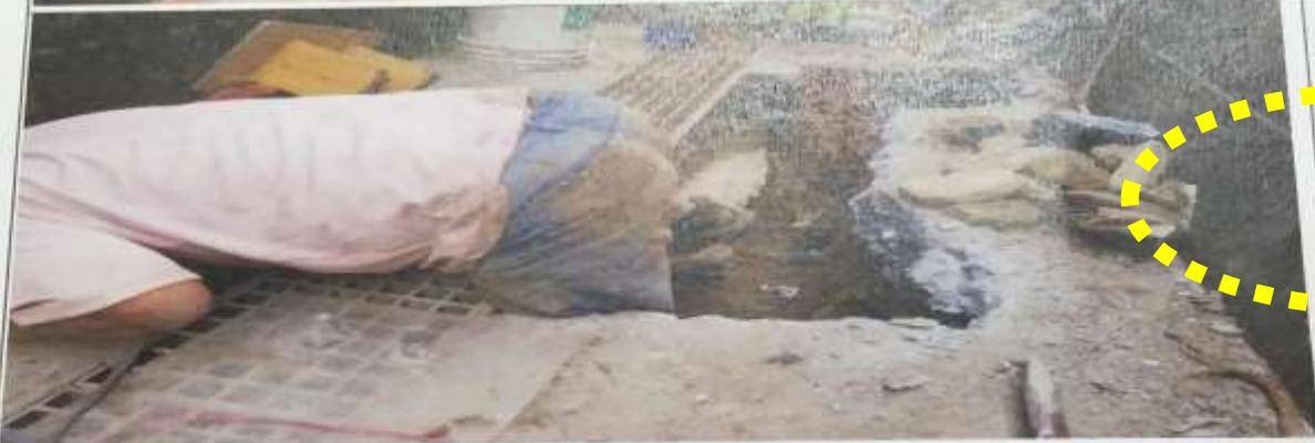
說明：埋設污排管之地坪敲擊線形凌亂, 重新打除後水泥粉光 (改善後)
