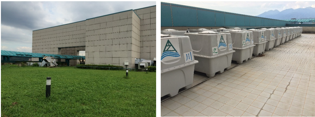
圖 4-2- 6 屋頂閒置空間現況照片
