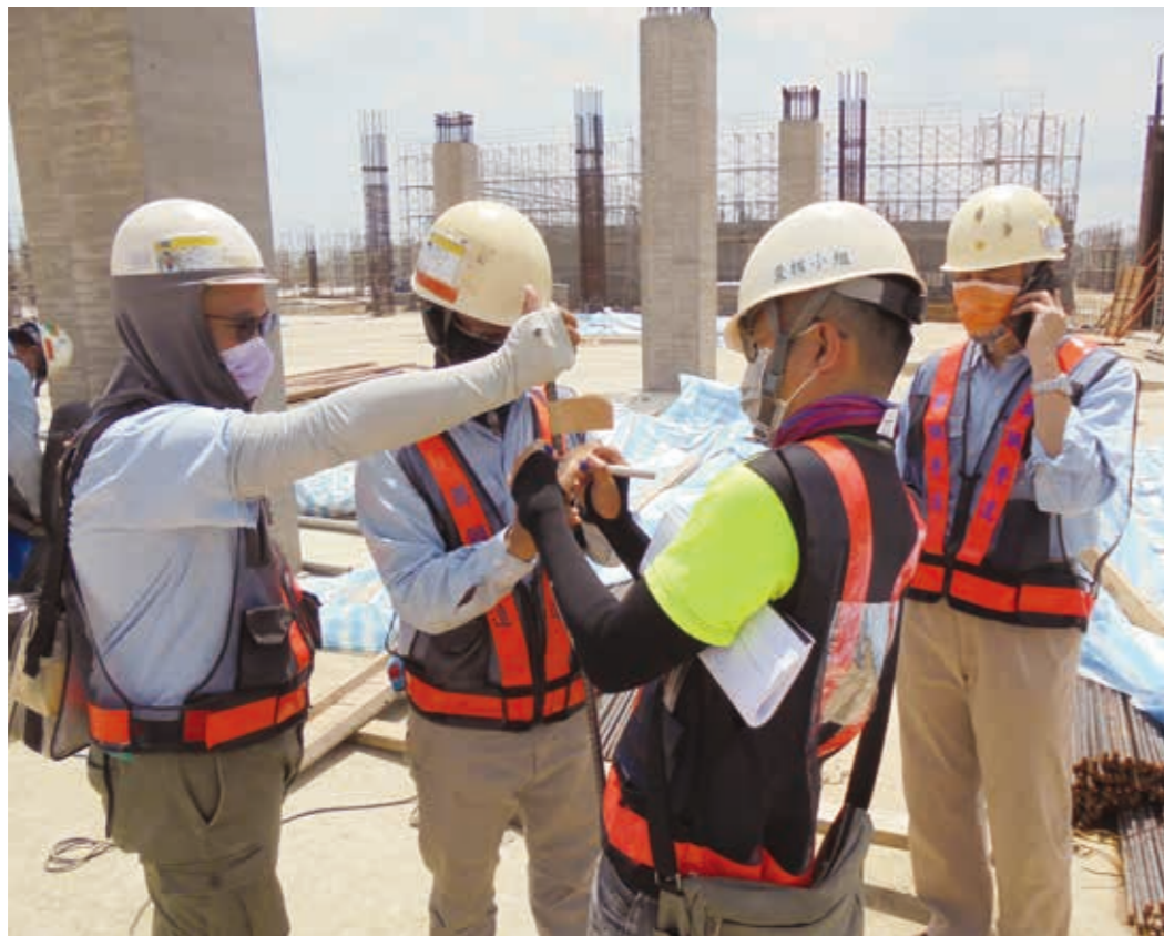
2021年9月15日國防部軍備局生產製造中心第205廠大樹北營區新建工程施工查核小組實地查核。
