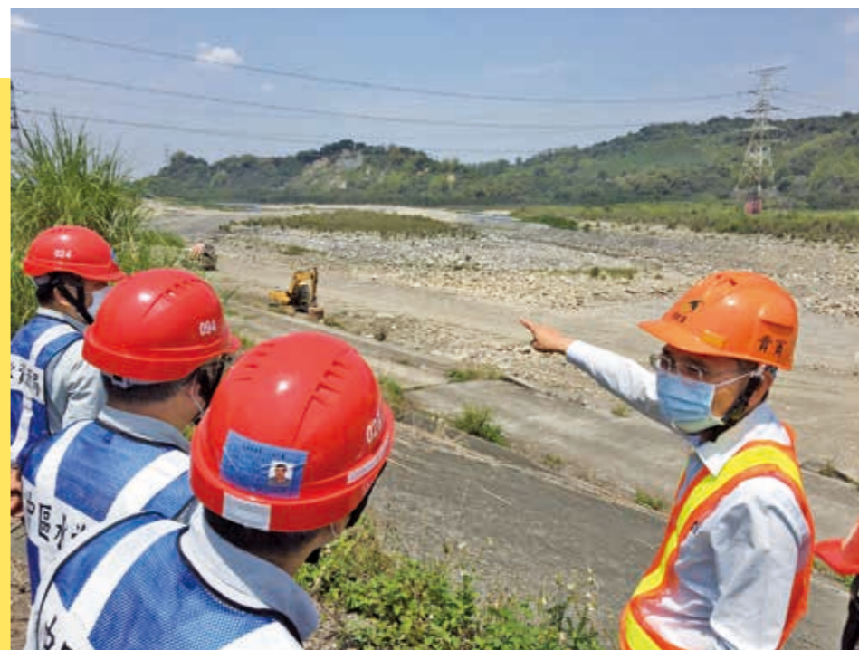
2020年4月15日經濟部水利署賴建信署長視導工地。
