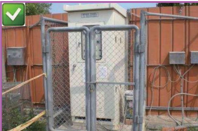
臨時電配電盤及變壓器圍設防護
