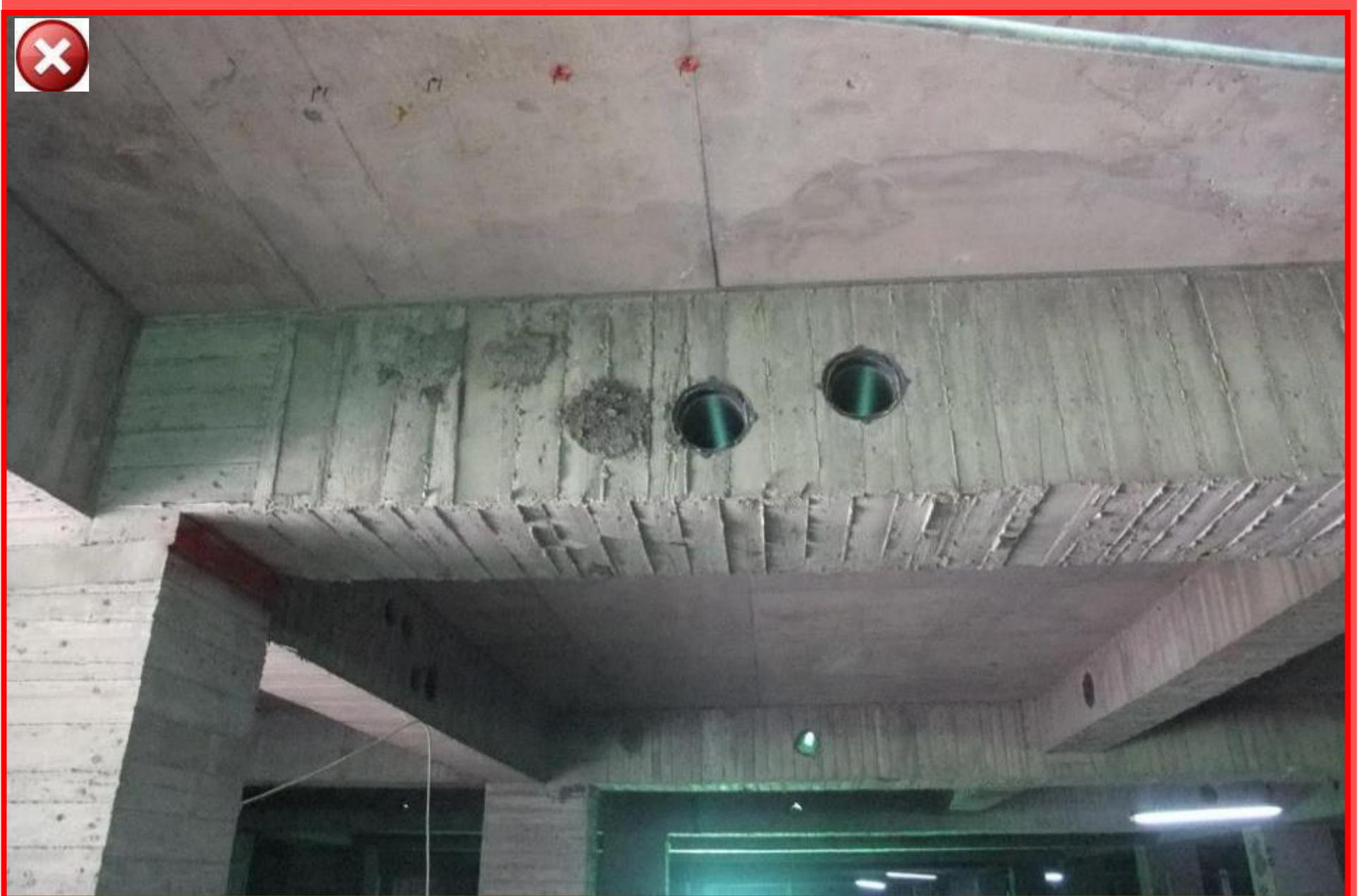
□5.07.05.99 屋頂給水應於泛水層上方穿越，且管路周邊縫隙應填補確實，以免破壞防水及管道間滲水
