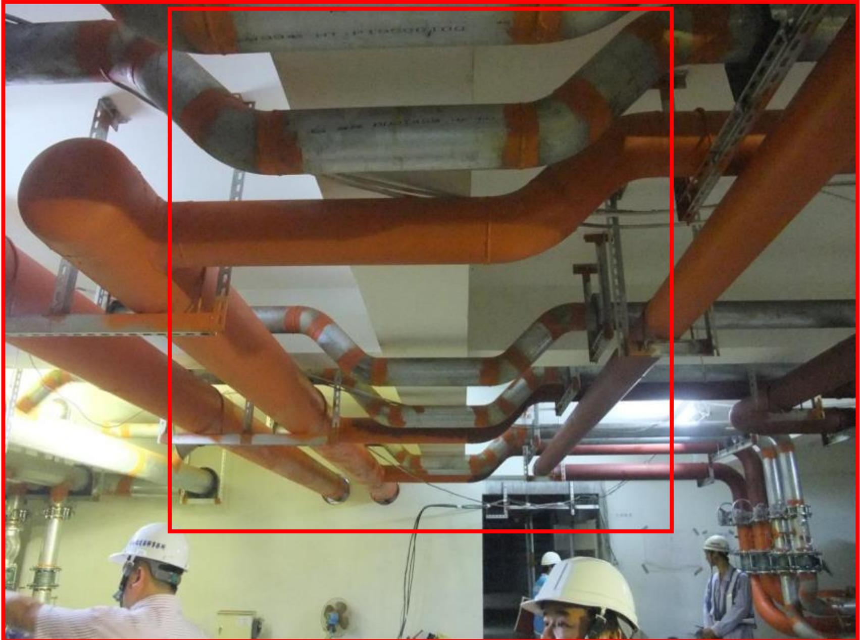
□5.07.05.03 管路以不穿梁為原則，穿梁時應依可穿孔位置區域及管徑限制規定施作，並以鋼筋補強
