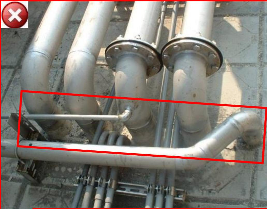
不銹鋼管及管件(突緣、螺栓及吊環等)應使用與管路相同之材料
