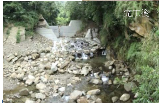
大埔區第53林班野溪治理工程
