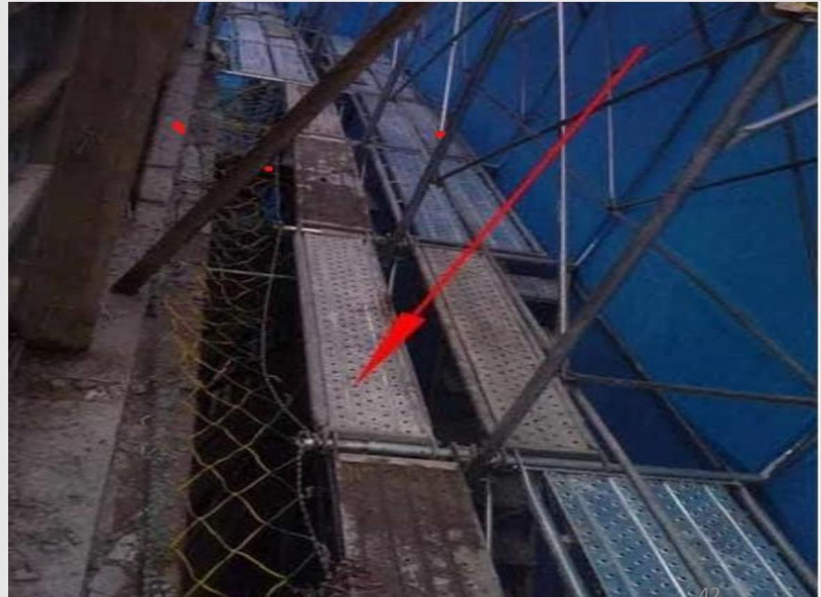
相關法規1：[營造安全衛生設施標準第45條](#)，施工架在適當之垂直、水平距離處與構造物妥實連接，其間隔在垂直方向以不超過五點五公尺，水平方向以不超過七點五公尺為限。
