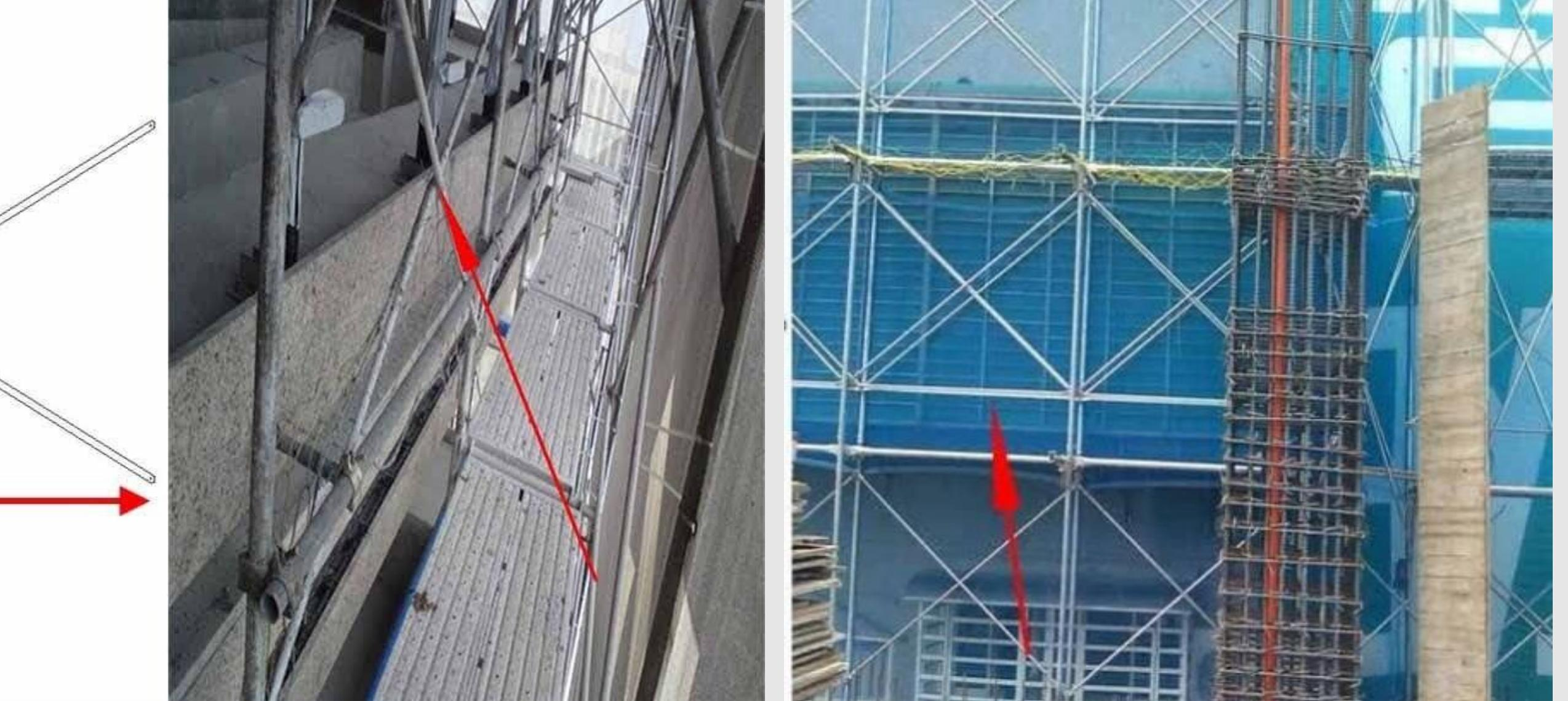
[職業安全衛生法第4條](#)，施工架內、外側應設置交叉拉桿，高度2公尺以上之施工架內、外側應增設下拉桿及施工架兩端立架及轉角處應設護欄，上下設備之交叉拉桿上方應設置適當護欄。
