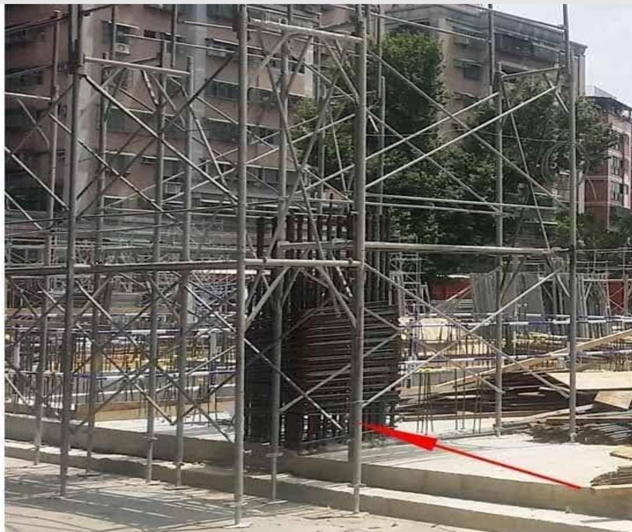
職業安全衛生法第4條，施工架內、外側應設置交叉拉桿，高度 2 公尺以上之施工架內、外側應增設下拉桿及施工架兩端立架及轉角處應設護欄，上下設備之交叉拉桿上方應設置適當護欄。
