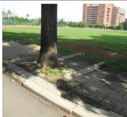
編號 23(損壞嚴重，舊有樹穴及鋪面清除加大樹穴，樹根需向下清除處理)
