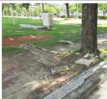
編號 23(損壞嚴重，舊有樹穴及鋪面清除加大樹穴，樹根需向下清除處理)
