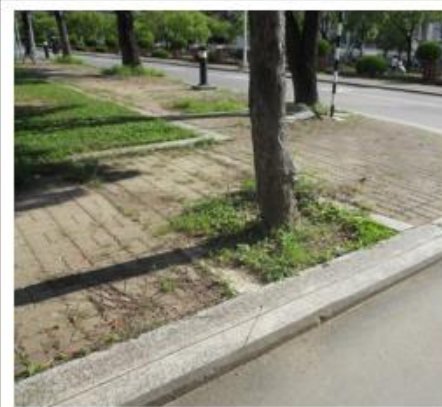
編號 22(損壞較輕微，加大植栽穴及整理鋪面平整度)
