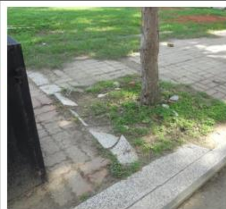
編號 24(損壞較輕微，加大植栽穴及整理鋪面平整度)
