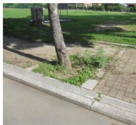
編號 22(損壞較輕微，加大植栽穴及整理鋪面平整度)
