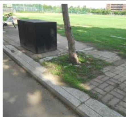
編號 24(損壞較輕微，加大植栽穴及整理鋪面平整度)
