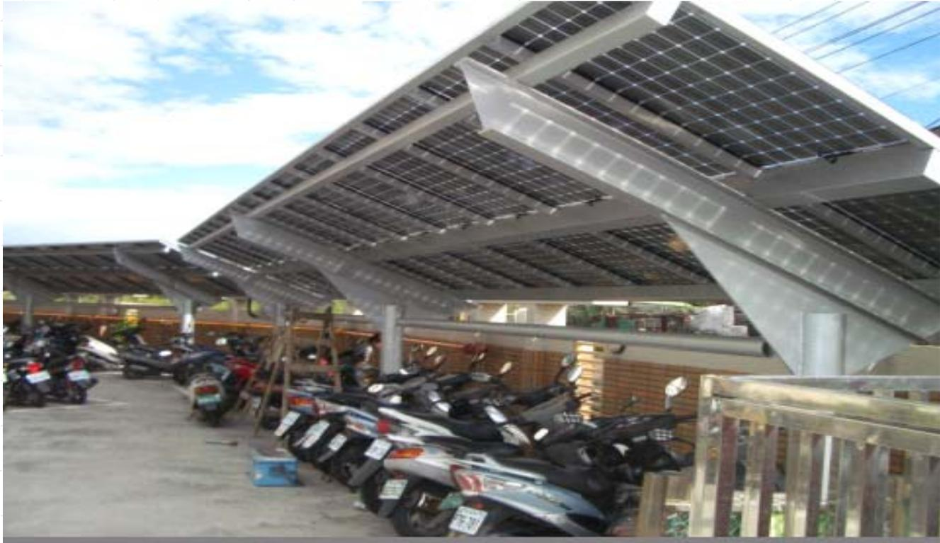
清雲科技大學10.5 kWp 停車棚PV發電系統
