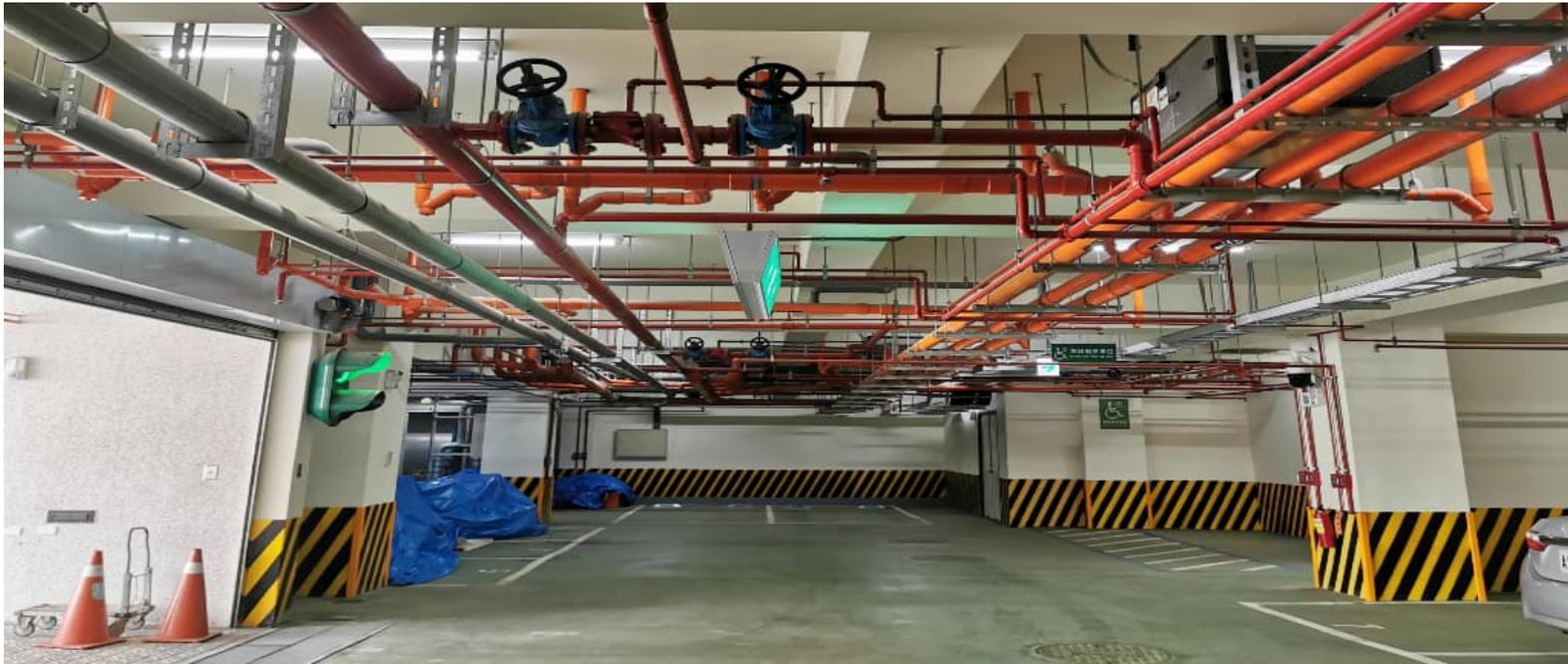
運用建築資訊模型 (BIM)，於施工前繪製數位模型先行檢討可能的碰撞衝突，先行解決，參照模型現場施工
