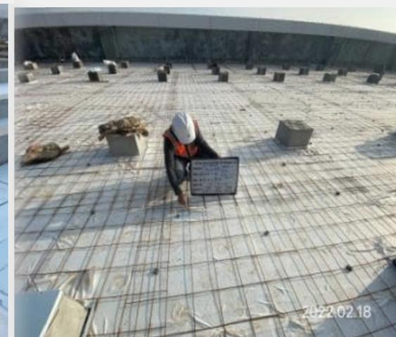
點焊鋼絲網20\*20\*4mm+混凝土澆置
