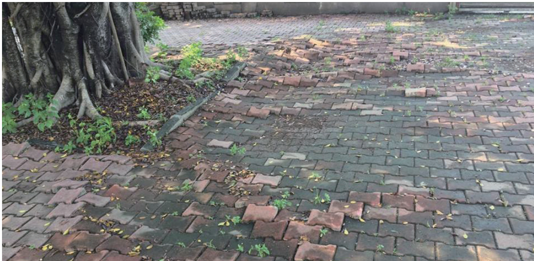
圖 1：樹根突出造成人行道磚塊隆起
