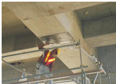
圖三 塗抹修補材
