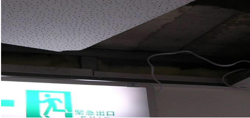
〈照片六〉 矽酸鈣輕隔間未封至頂板
