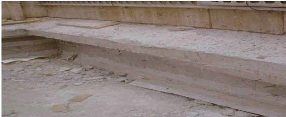
〈照片二-1〉 泛水收邊繞牆施做不中斷
