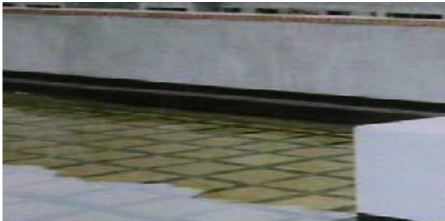
〈照片四〉屋頂防水層試水試驗
