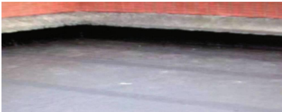
〈照片二-2〉 泛水收邊繞牆施做不中斷
