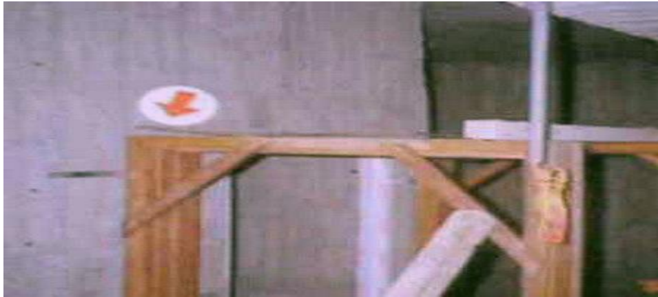
〈照片八-3〉 混凝土牆側以鋼筋補強支撐
